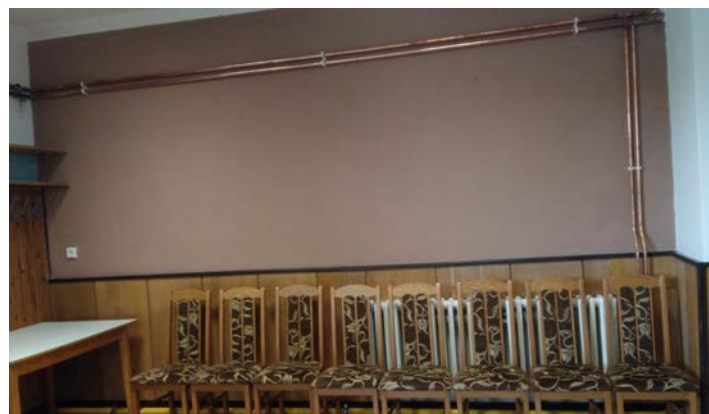
Nové rozvodové trubky v budově Obecního úřadu v Počenicích.
