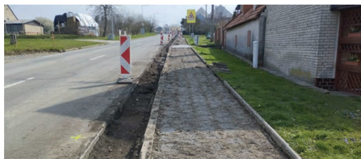
Předláždění chodníku v Tetěticích.
